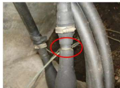
Fig. 7. Empalme Defectuoso. [5]
