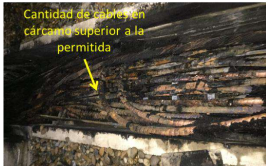
Fig. 2. Disposición Inadecuada en cárcamos
